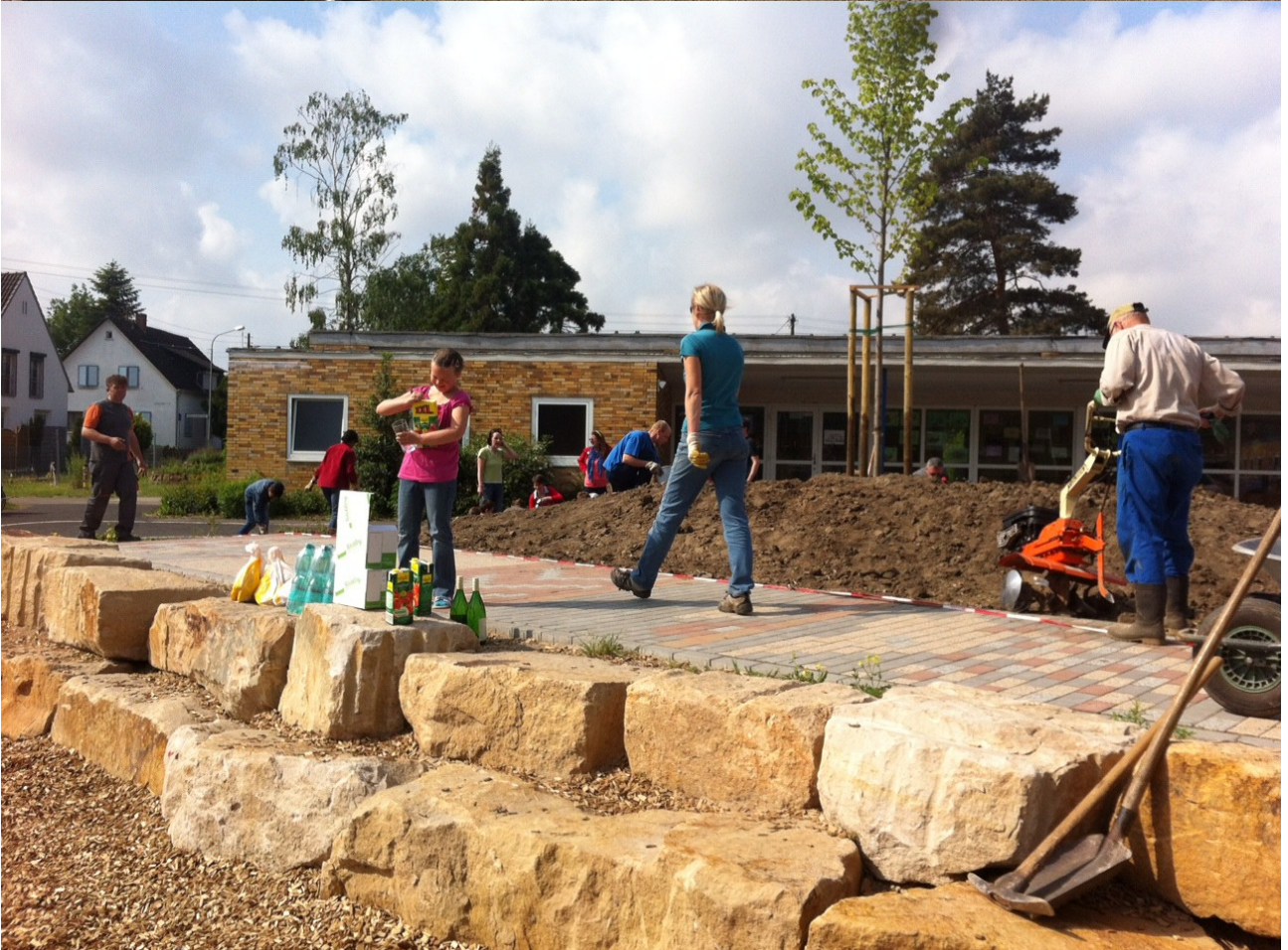
Arbeiten am Hügel / Bepflanzung
